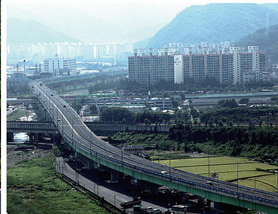
내서-중리간 도로 4차선 축조공사
