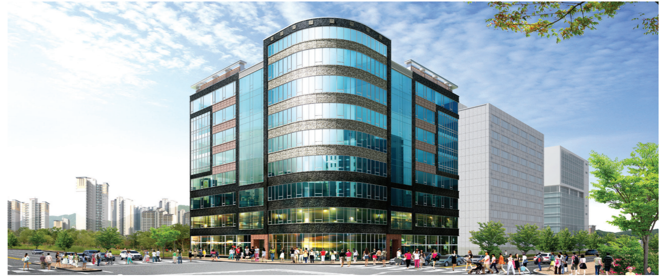
친환경 건축물로 뛰어난 외관을 자랑하는 백상건설의 강남 리더스프라자 조감도
