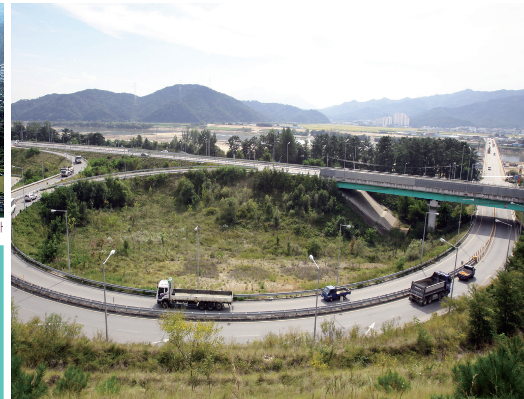
상림-해평간 도로 4차선 확장공사
