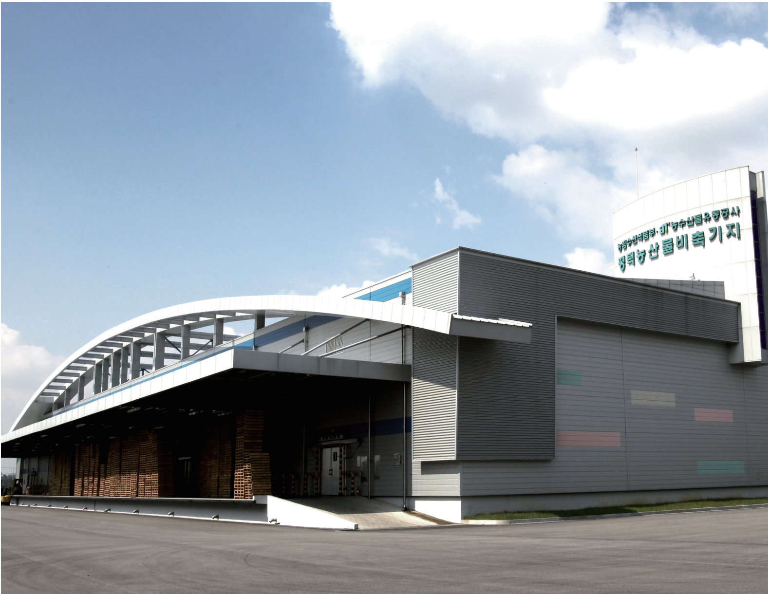
농수산물유통공사 평택비축기지 건립공사
