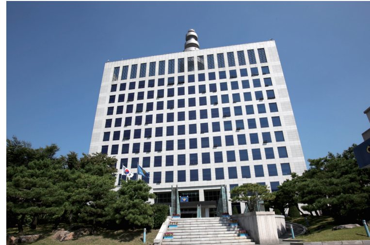
대구 지방경찰청 청사 신축공사
