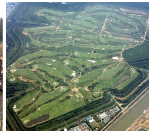
드림파크 골프장 공사
