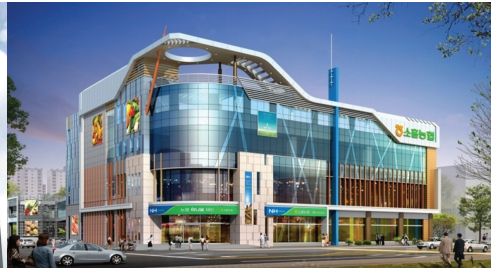
소홀농협 종합시설 신축공사
