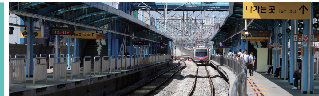
경인 복복선 전철 노반시설공사
